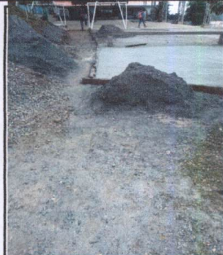
Foto 1: Sustitución de torta de concreto el avance que se ha realizado en estas semanas
