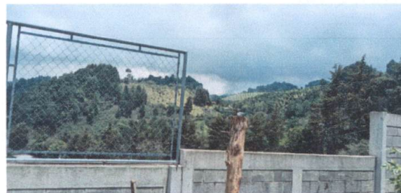
Foto 4: Suministro e instalación de tubo hg y malla galvanizada en el muro perimetral, el cual no estaba estaba completo ya se avanzo en esa area casi en su totalidad
