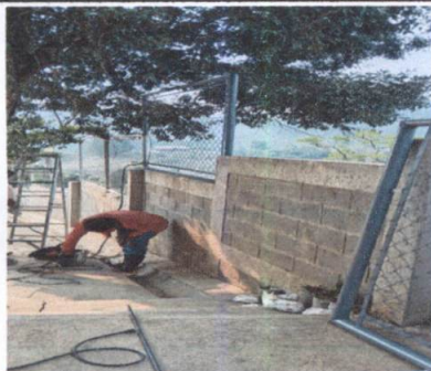
Foto 3: Suministro e instalación de tubo hg y malla galvanizada en el muro perimetral, el cual no estaba estaba completo ya se avanzo en esa area casi en su totalidad
