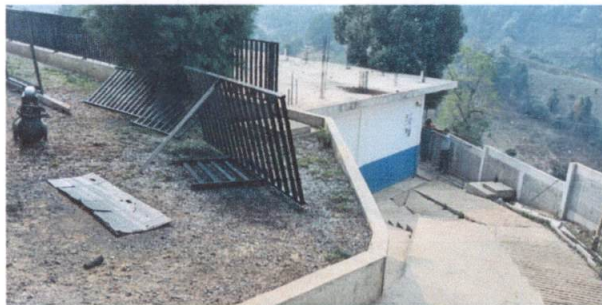
Foto 2: Mantenimiento de barandas de metal, se pintaron y las cuales se eestan colocando en el área del muro
