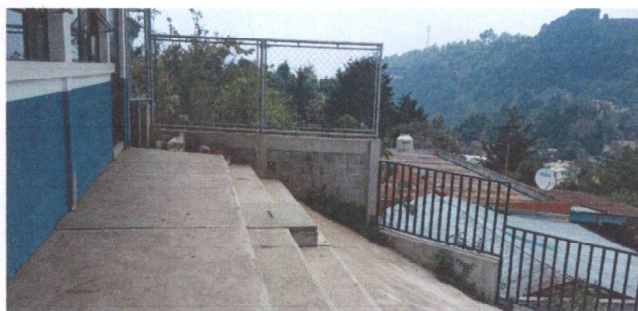
Foto 9: Instalacion de pila y chorro
