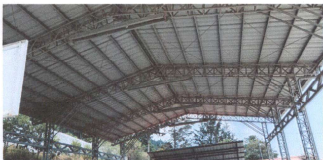
Foto 7: Sustrucción de lamparas LED para mayor iluminacion
