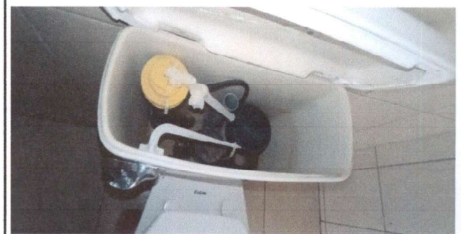
Foto 4: Sustitución de accesorios de 4 inodoros
