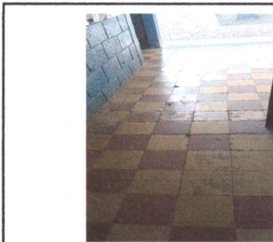
Foto 3: Sustitución de piso cerámico de 4 salones y un corredor
