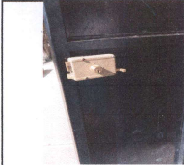
Foto 1: Cambio de chapa de 1 salón
