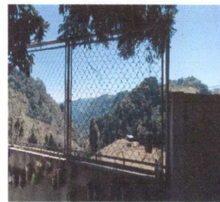
Foto 6: Suministro e instalación de tubo hg y malla galvanizada en el muro perimetral
