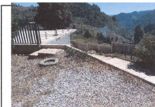
Foto 5: Mantenimiento de barandas de metal, colocando en el área faltante
