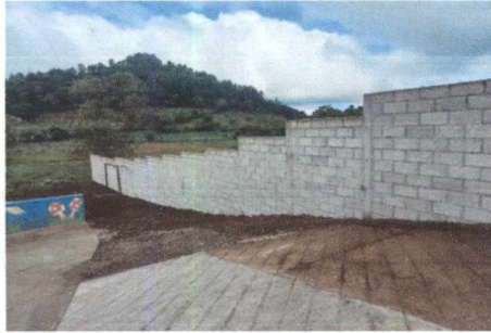
FOTO 3: REPARACIÓN DE TORTA DE CONCRETO
