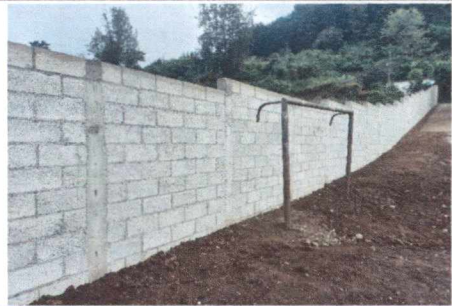
FOTO 6: REPARACIÓN DE MURO PERIMETRAL
