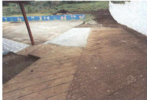
FOTO 2: REPARACIÓN DE TORTA DE CONCRETO
