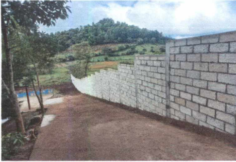
FOTO 1: REPARACIÓN DE MURO PERIMETRAL
