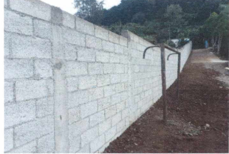
FOTO 4: REPARACIÓN DE MURO PERIMETRAL
