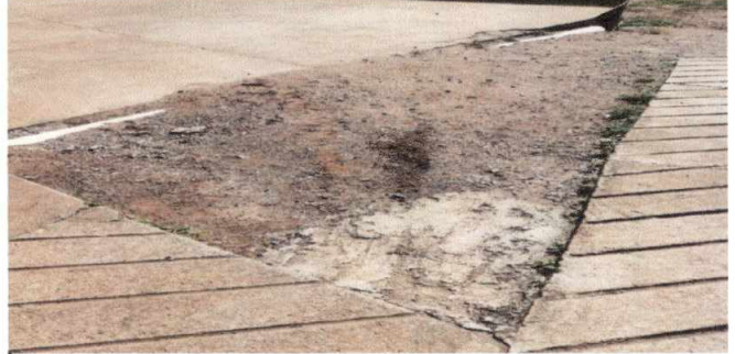
Foto 2: REPARACION DE TORTA DE LA RAMPA DE LA ENTRADA PRINCIPAL.
