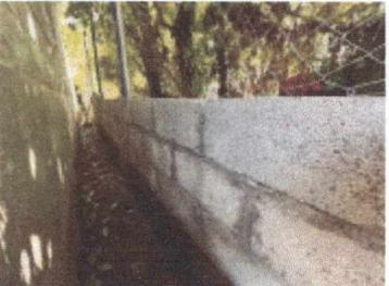
REPARACIÓN DE MURO PERIMETRAL CON BLOCK Y TUBO HG CON MALLA GALVANIZADA
