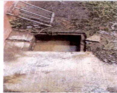
Foto 4: Reparación de caja de drenaje enfrente de la escuela.
