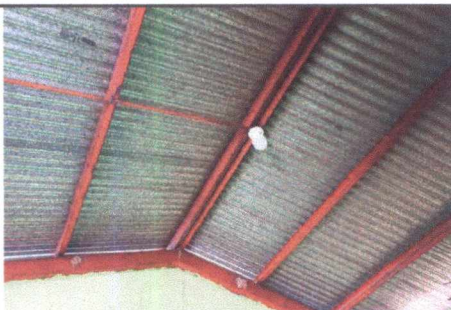
FOTO 5: SUSTITUCIÓN DE UNIDADES DE LUZ
