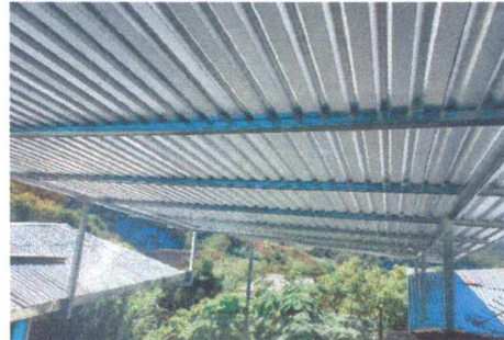
FOTO 10: SUSTITUCIÓN DE ESTRUCTURA PORTANTE DE METAL
