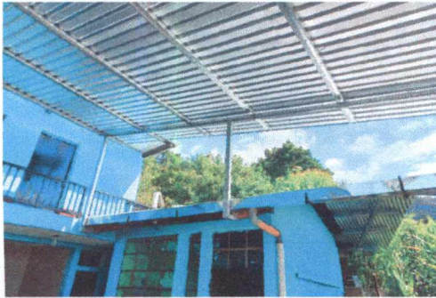
FOTO 1: SUSTITUCIÓN DE LÁMINA POR LÁMINA TROQUELADA CALIBRE 26
