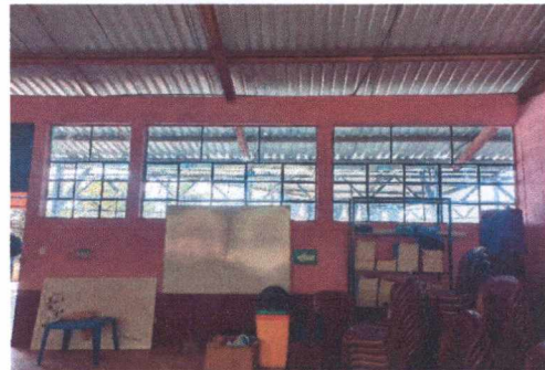
FOTO 2: APLICACIÓN DE PINTURA EN MUROS INTERIORES
