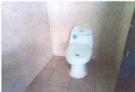
FOTO 3: SUSTITUCIÓN DE INODOROS
