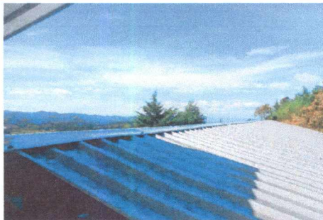
FOTO 9: SUSTITUCIÓN DE CAPOTE EN CUBIERTA DE LÁMINA
