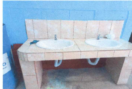
FOTO 4: SUSTITUCIÓN DE MEZCLADORAS EN LAVAMANOS Y SIFONES
