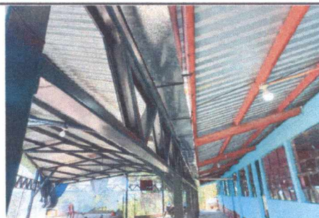
FOTO 12: MANTENIMIENTO A ESTRUCTURA DE SOPORTE DE METAL Y APLICACIÓN DE PINTURA EN MUROS EXTERIORES
