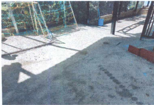
FOTO 7: SUSTITUCIÓN DE PISO DE CONCRETO EN PATIO
