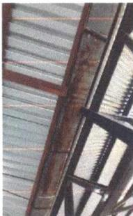
Foto 5: Quitado y sustitución de canal hechizo de metal. Actualmente el canal está oxidado y en su mayoría está roto provocando que el agua caiga en el patio y se entre el agua a la escuela cuando llueve.
