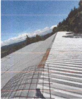
Foto 1: Sustitución de capote en mal estado de mala calidad y no es el adecuado para lámina troquelada, por lo tanto
