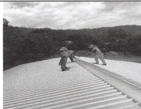
Foto 6: Vista superior para visualizar el techo ya instalado con su respectivo capote.
