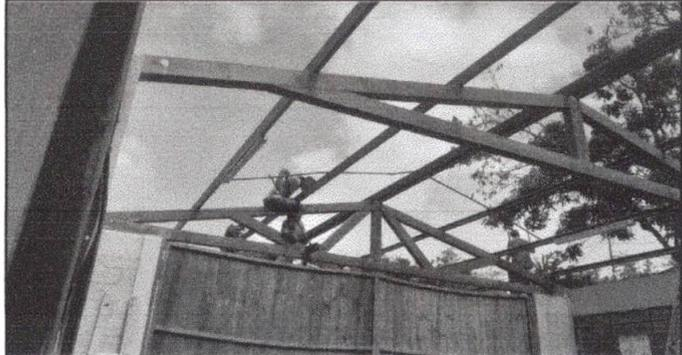
Foto 2: Se Cambiarán 20 X 11.25 metros de techo (renglón 1.1) a 2 aguas, con sus respectivos capotes (renglón 1.1) y elementos de fijación (renglón 1.3) Remodelación de Iluminación y fuerza.
