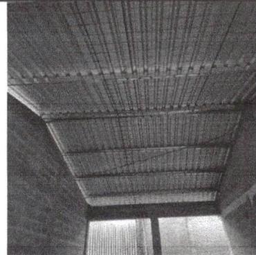
Foto 4: Se agregarán: costaneras (renglón 2.3), lámina aluzinc (renglón 1.1), canales (renglón 7.1) y pescantes (renglón 7.5), capotes (renglón 1.1) y elementos de fijación (renglón 1.3). Así como: 19.2 M2 de ventanas-balcones (renglón 19.1)
