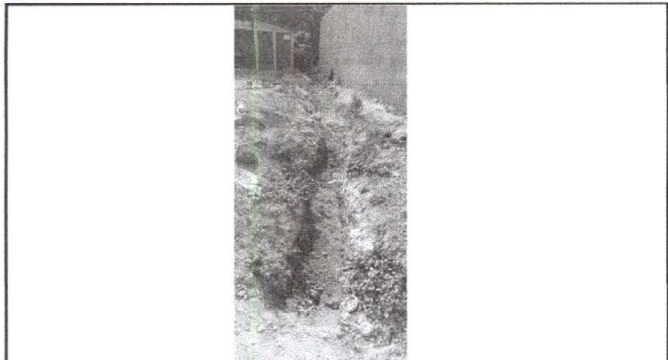
Foto 9: Se espera agregar 25 metros lineales de cuneta (renglón 8.1) para las caídas de aguas pluviales.
