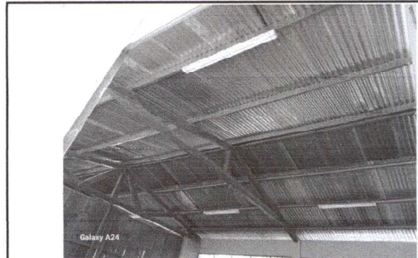
Foto 2: Se Cambiarán 20 X 11.25 metros de techo (renglón 1.1) a 2 aguas, con sus respectivos capotes (renglón 1.1) y elementos de fijación (renglón 1.3) Remodelación de Iluminación y fuerza.
