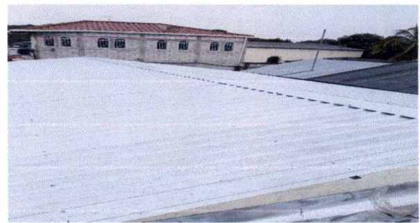
Foto 4: SUSTITUCION DE LAMINA, TROQUELADA ALUZINC CALIBRE 26 Y DE CAPOTE
