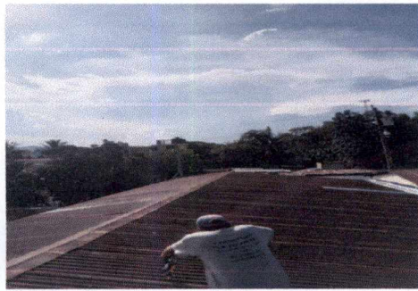
Foto 3: SUSTITUCION DE LAMINA, TROQUELADA ALUZINC CALIBRE 26 Y DE CAPOTE
