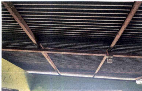
MANTENIMIENTO DE ESTRUCTURA DE SOPORTE
