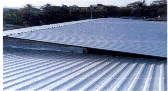
Foto 2: SUSTITUCION DE LAMINA, POR LAMINA TROQUELADA ALUZINC CALIBRE 26 Y DE CAPOTE
