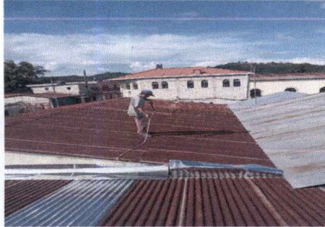
Foto1: SOSTITUCION DE LAMINA, POR LAMINA TROQUELADA ALUZINC CALIBRE 26
