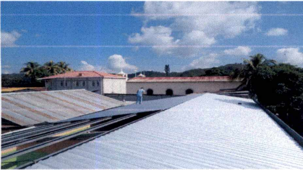
Foto1: SOSTITUCION DE LAMINA, POR LAMINA TROQUELADA ALUZINC CALIBRE 26
