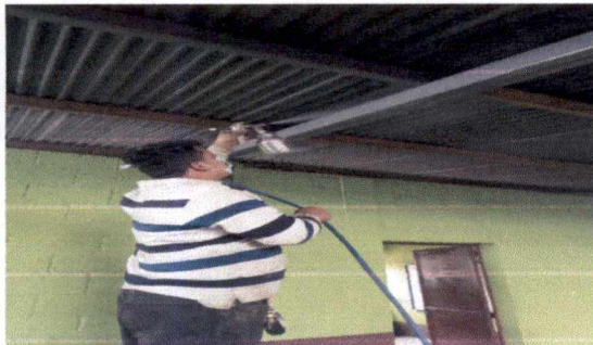
MANTENIMIENTO DE ESTRUCTURA DE SOPORTE
