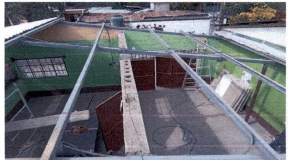
Foto 4: SUSTITUCION DE LAMINA, TROQUELADA ALUZINC CALIBRE 26 Y DE CAPOTE
