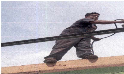
Foto 3: SUSTITUCION DE LAMINA, TROQUELADA ALUZINC CALIBRE 26 Y DE CAPOTE
