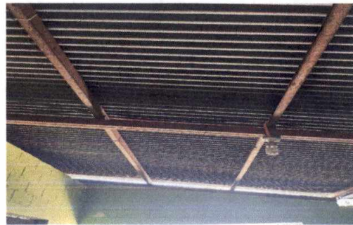
MANTENIMIENTO DE ESTRUCTURA DE SOPORTE
