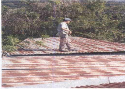
Foto1: SUSTITUCION DE LAMINA, POR LAMINA TROQUELADA ALUZINC CALIBRE 26
