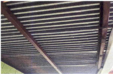
MANTENIMIENTO DE ESTRUCTURA DE SOPORTE
