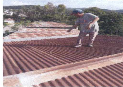
Foto 2: SUSTITUCION DE LAMINA, POR LAMINA TROQUELADA ALUZINC CALIBRE 26 Y DE CAPOTE
