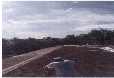
Foto 4: SUSTITUCION DE LAMINA, TROQUELADA ALUZINC CALIBRE 26 Y DE CAPOTE
