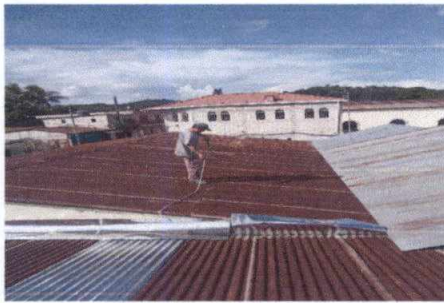
Foto 3: SUSTITUCION DE LAMINA, POR LAMINA TROQUELADA ALUZINC CALIBRE 26
