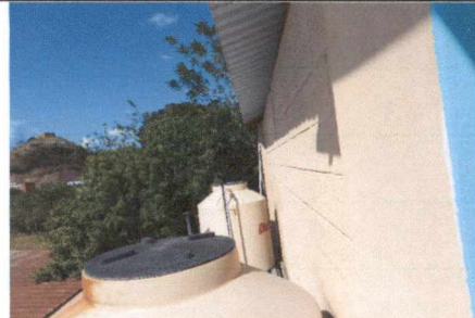
FOTO 6: SUSTITUCIÓN DE ACCESORIOS DE DEPÓSITO DE AGUA
