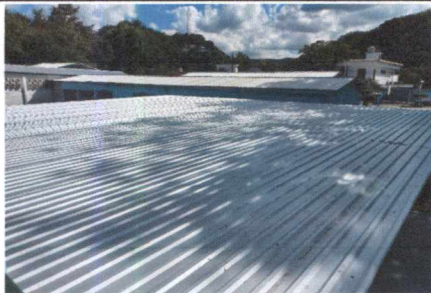
FOTO 5: SUSTITUCIÓN DE LÁMINA EN ÁREA DE PATIO
