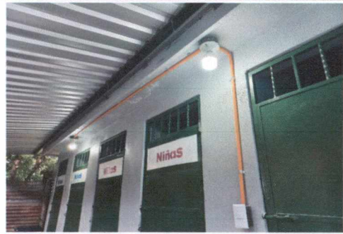
FOTO 2: SUSTITUCIÓN DE LÁMPARAS EN ÁREA DE SANITARIOS
