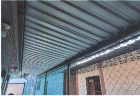
FOTO 1: SUSTITUCIÓN DE LÁMINA EN ÁREA DE SANITARIOS
