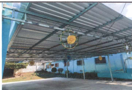
FOTO 4: INSTALACIÓN DE ESTRUCTURA Y CUBIERTA DE LÁMINA EN PATIO
