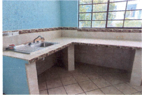
FOTO 2: INSTALACIÓN DE AZULEJO EN COCINA
