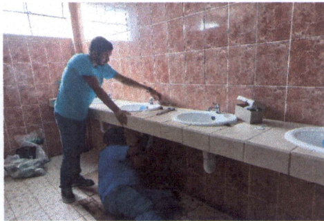
FOTO 3: SUSTITUCIÓN DE MEZCLADORAS EN 6 LAVAMANOS
