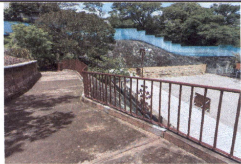
FOTO 6: MANTENIMIENTO A BARANDAS DE METAL
