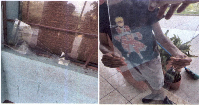
Foto 1. Sustitución de vidrios en ventanas de aulas
