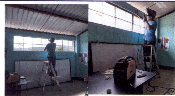
Foto 4: Sustitución de estructura de metal de ventana
