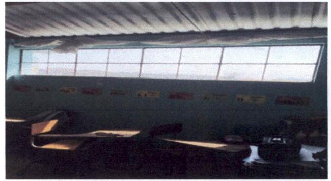
Foto 4: Sustitución de estructura de metal de ventana
