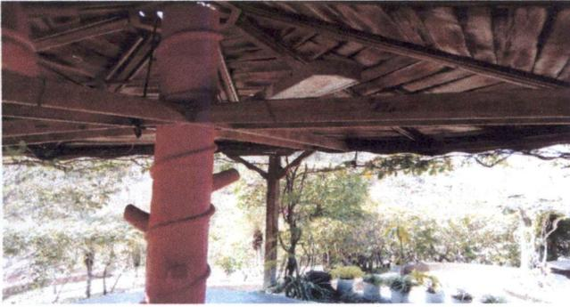
Foto 1: Sustitución por lámina troquelada
