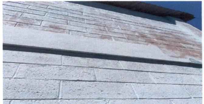
Foto 6: Pintura de paredes exteriores
