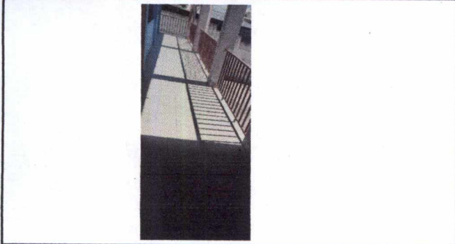
foto 7: Vista del corredor izquierdo de segundo nivel
