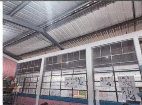
Foto 10: Sustitución de estructura de ventana mas vidrio
