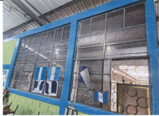
Foto 8: Sustitución de estructura de ventana mas vidrio
