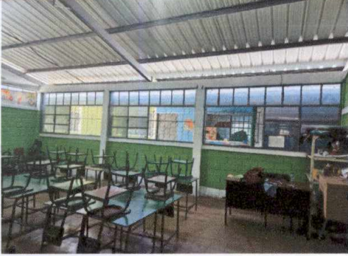
Foto 13: sustitución de vidrio
