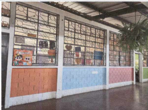
Foto 5: Mantenimiento de balcones de metal, pintura
