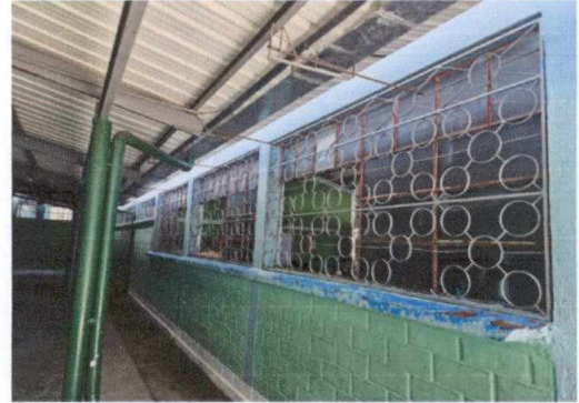
Foto 14: Mantenimiento de balcones de metal, pintura
