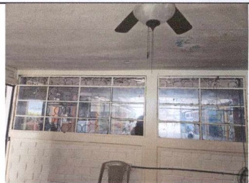
Foto 2: Sustitución de estructura de ventana y vidrio
