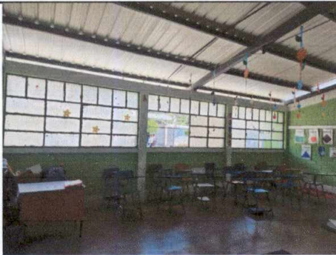
Foto 11: sustitución de vidrio
