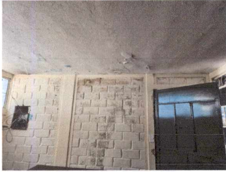
Foto 19: Impremeabilización en terraza.
