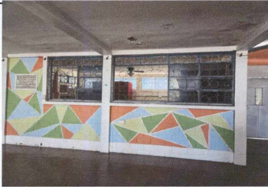
Foto 1: Mantenimiento de balcones de metal, pintura
