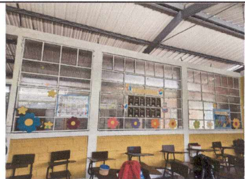
Foto 4: Sustitución de estructura de ventana y vidrio
