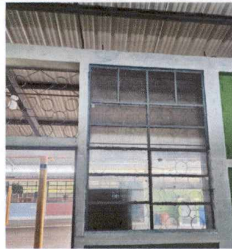
Foto 18: Sustitución de estructura de ventana mas vidrio
