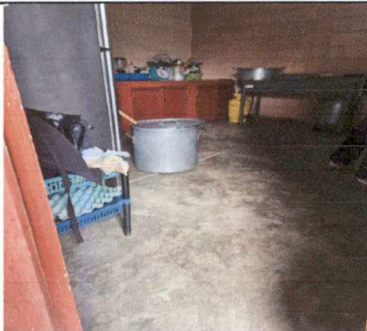
Foto 23: Sustitución de piso de torta de concreto por piso ceramico.
