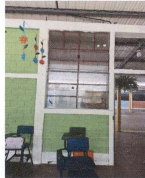
Foto 16: Sustitución de estructura de ventana mas vidrio
