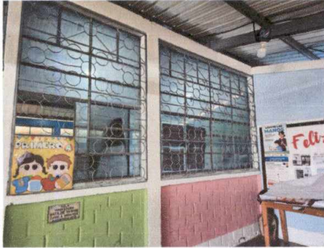
Foto 7: Mantenimiento de balcones de metal, pintura
