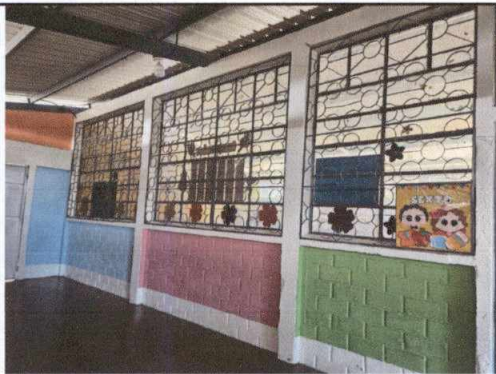
Foto 3: Mantenimiento de balcones de metal, pintura
