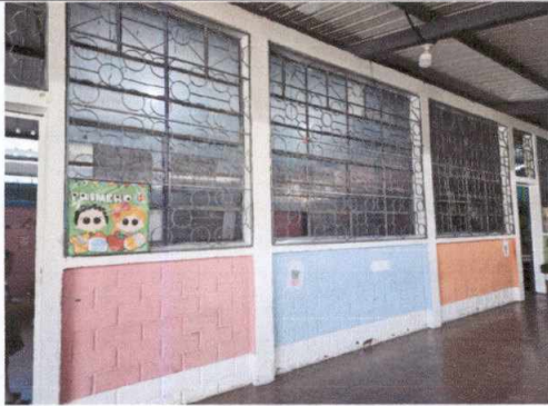
Foto 9: Mantenimiento de balcones de metal, pintura
