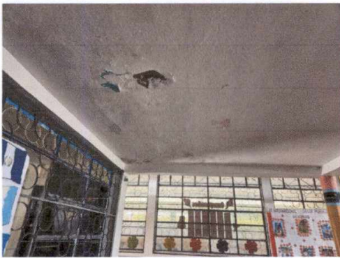
Foto 21: Impremeabilización en terraza.
