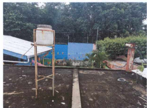
Foto 22: Impremeabilización en terraza.
