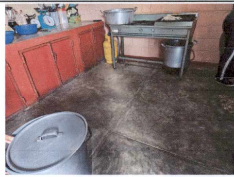
Foto 24: Sustitución de piso de torta de concreto por piso ceramico.
