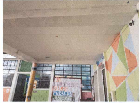
Foto 20: Impremeabilización en terraza.
