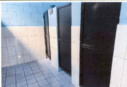
FOTO 3: MANTENIMIENTO DE PUERTAS DE SERVICIOS SANITARIOS
