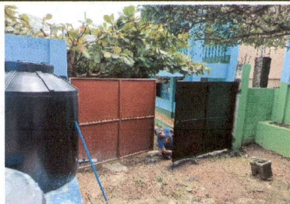
FOTO 4: MANTENIMIENTO A PORTÓN CON UN AVANCE DEL 50%
