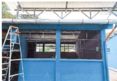
FOTO 2: MEJORAMIENTO DE VENTANA DE METAL POR VENTANA CORREDIZA
