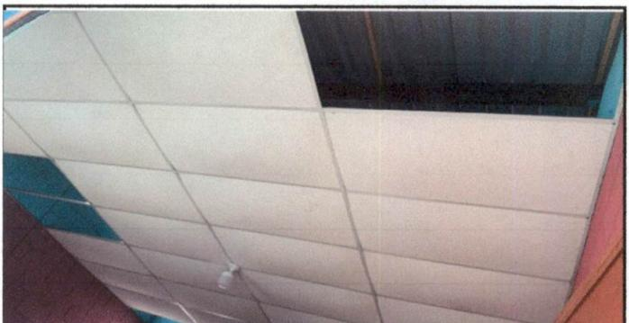
Foto 6: se hizo cambio de lamina para evitar que el cielo falso se siga deteriorando.
