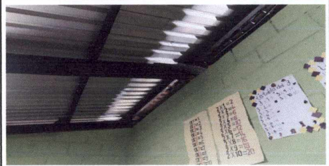
Foto 2: Sustrucción de estructura de madera por metal
