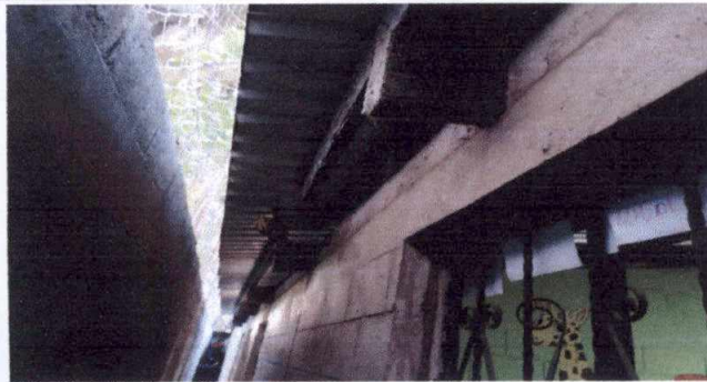
Foto 1: Sustrucción de estructura de madera por metal
