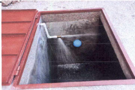
FOTO 3: IMPLEMENTACIÓN DE CISTERNA
