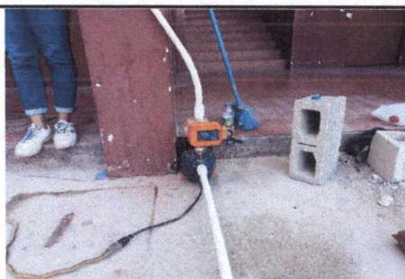
FOTO 4: INSTALACIÓN DE BOMBA DE 1HP
