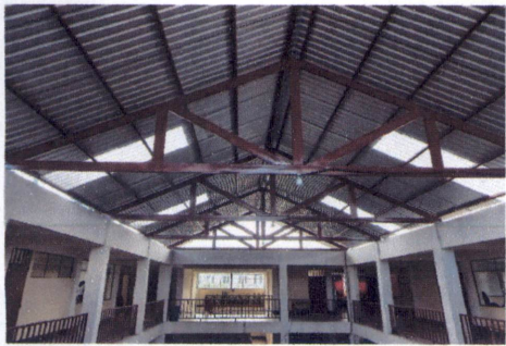
FOTO 1: INSTALACIÓN DE LÁMINA TROQUELADA ALUZINC CALIBRE 26
