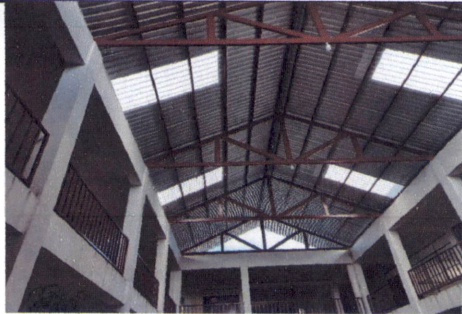
FOTO 2: INSTALACIÓN DE ESTRUCTURA DE SOPORTE DE METAL
