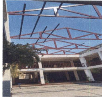
Foto 2: Techo sobre el patio.
