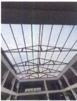
Foto 3: Techo sobre el patio.
