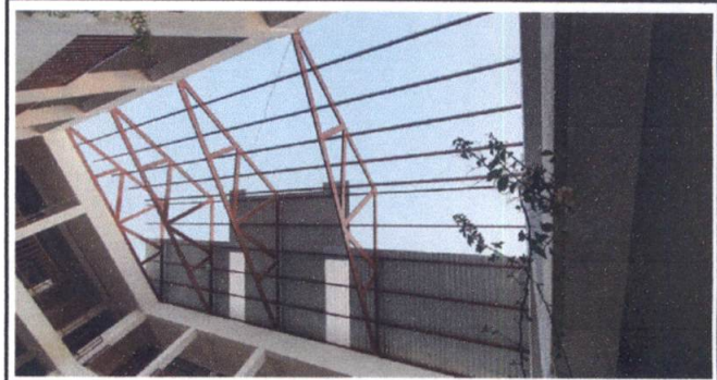
Foto 4: Techo sobre el patio.
