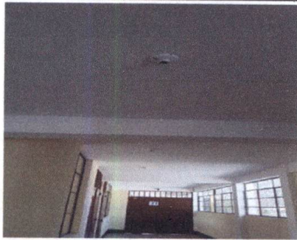
Foto 3: Sustrucción de focos ahorradores.
