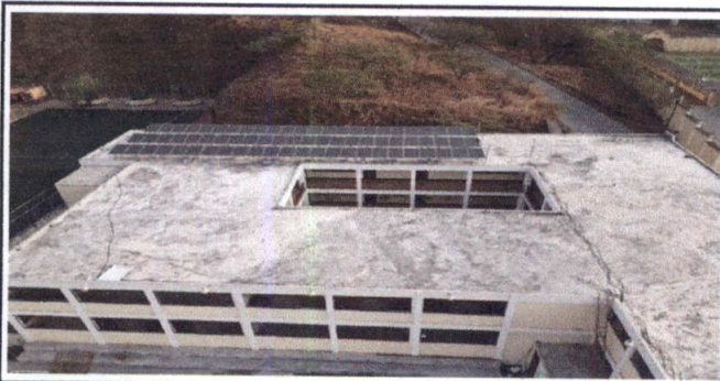
Foto 5: Techo sobre el patio.
