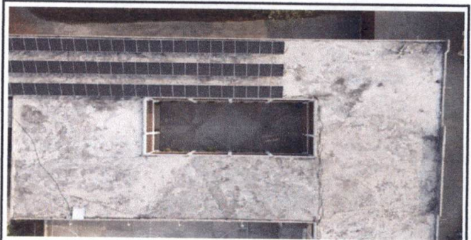
Foto 6: Techo sobre el patio.
