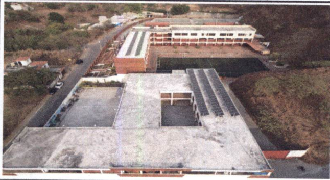
Foto1: Techo sobre el Patio
