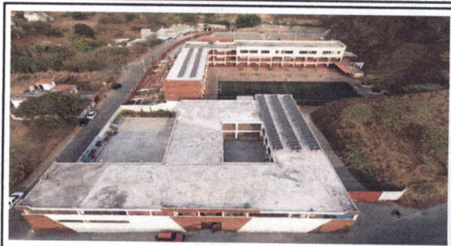
Foto 2: Techo sobre el patio.
