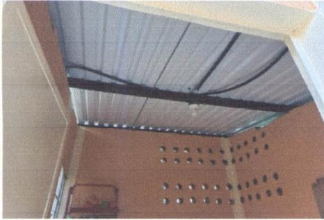
FOTO 1: INSTALACIÓN DE LAMINA TROQUELADA CALIBRE 26
