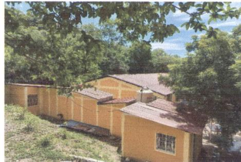
FOTO 10: APLICACIÓN DE PROTECCIÓN ANTICORROSIVA EN TECHOS.
