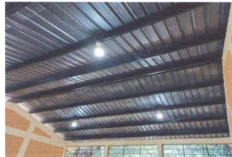
FOTO 4: INSTALACIÓN DE LÁMPARAS LED EN AULAS Y CORREDOR
