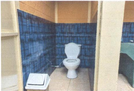
FOTO 3: SUSTITUCIÓN DE INODOROS E INSTALACIÓN DE AZULEJO
