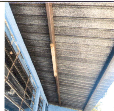
Foto 4: Reparación de lamparas.
