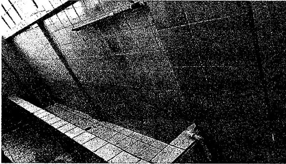
Foto 1: Miguitorio con filtración y fuga de agua en la pared y al mismo tiempo tapado. La misma pared necesita reparación de fisuras por fugas, repello y cernido.
