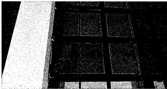
Foto 3: Instalación de balcones de metal, para proteger los vidrios de las ventanas.
