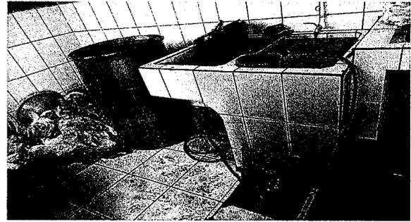
Foto 2: Sustitución de pila, por pila de 2 o 3 lavaderos aereos.
