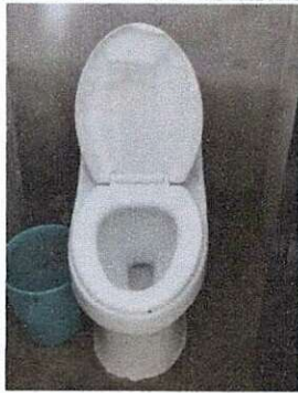
Foto1: Sustitución de lavamanos servicio sanitario de niñas.
