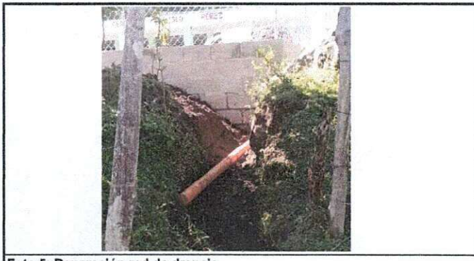
Foto 5: Reparación red de drenaje.
