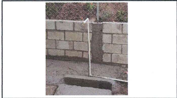
Foto 2: Reparación red de agua potable.
