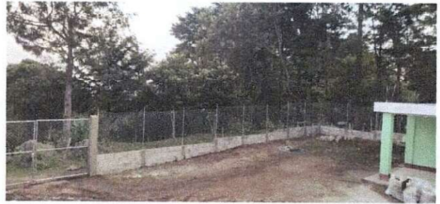
Foto 4: Cerco o muro perimetral.
