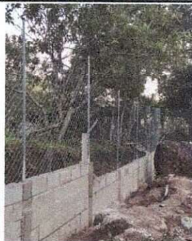
Foto 5: Cerco o muro perimetral.
