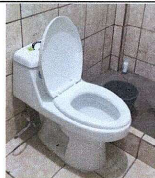
Foto 4: Sustitución de inodoro servicio sanitario de maestros.
