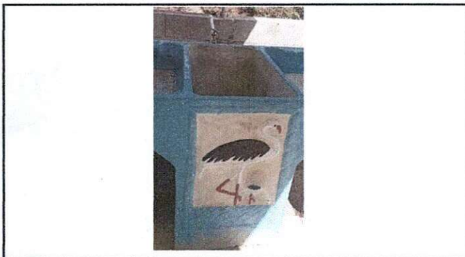
Foto 3: Sustitución de pila de dos lavaderos.
