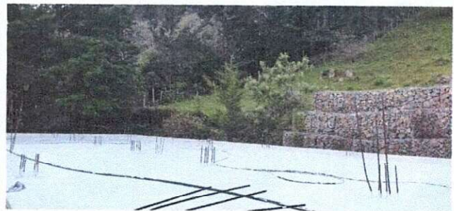
Foto 6: Impermeabilización de losa
