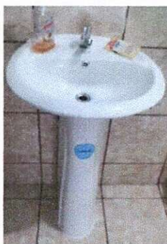
Foto 3: Sustitución de lavamanos servicio sanitario de maestros.
