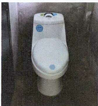
Foto 5: Sustitución de inodoro servicio sanitario de niños.
