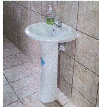
Foto 2: Sustitución de lavamanos servicio sanitario de niñas.
