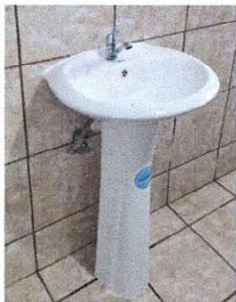
Foto 1: Sustitución de lavamanos servicio sanitario de niños.
