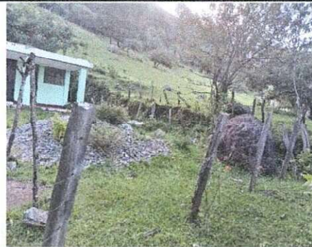
Foto 2: Falta de cerco o muro perimetral
