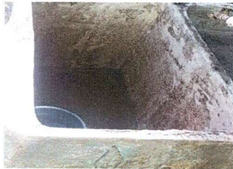
Foto 4: Sustitución de pila dos lavaderos.
