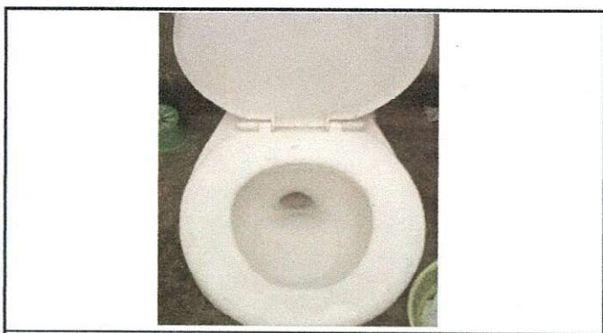
Foto 6: Sustitución de inodoro servicio sanitario de maestros.
