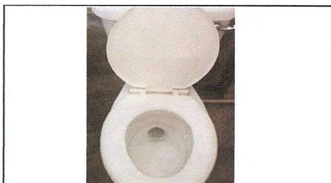
Foto 4: Sustitución de inodoro servicio sanitario de niñas.
