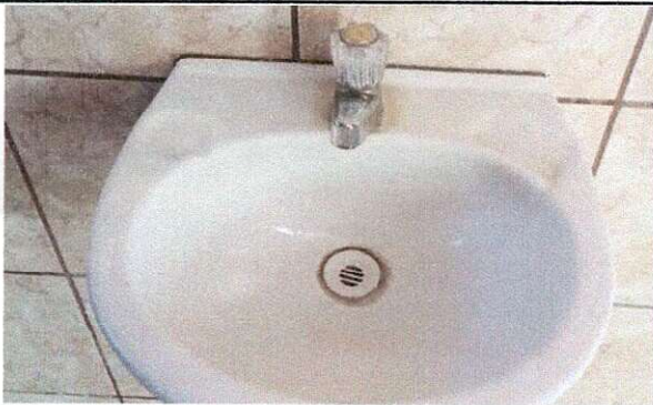
Foto 3: Sustitución de lavamanos servicio sanitario de maestros.
