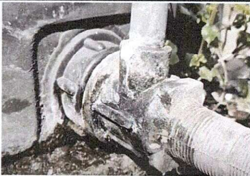
Foto 5: Reparación de cisterna.
