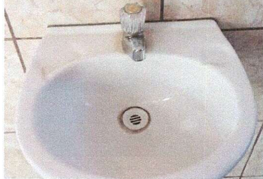
Foto 2: Sustitución de lavamanos servicio sanitario de niñas.
