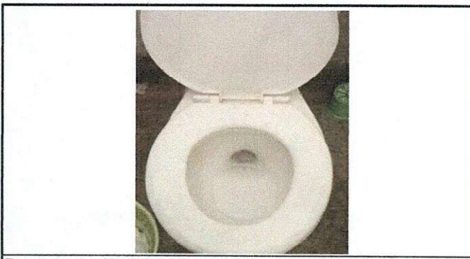
Foto 5: Sustitución de inodoro servicio sanitario de niñas.
