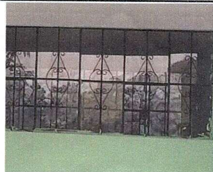
Foto 6: Mantenimiento de ventanas.
