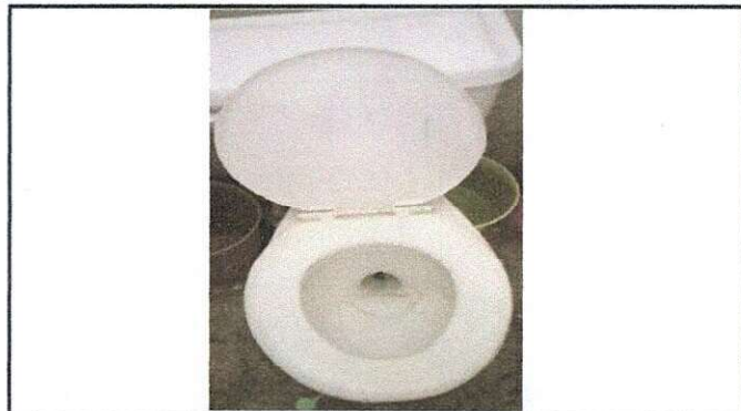
Foto 2: Sustitución de inodoro servicio sanitario de niños.
