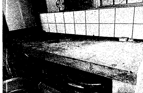
Top de cemento dañado: construcción de top de cemento y forrado de azulejo por estar gretado
