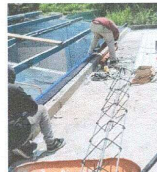
Foto 4: Sustituyendo la costanera en mal estado
