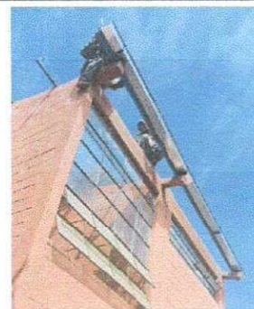
Foto 6: Instalando canal y bajada pluvial
