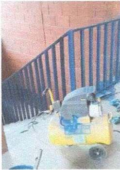
Foto 7: Mantenimiento de baranda
