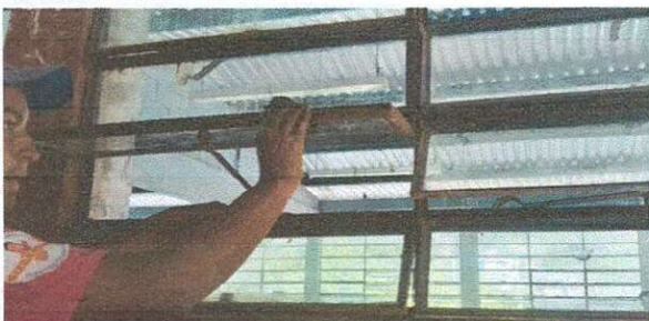
Foto 5: Sustituyendo ventanas de vidrio
