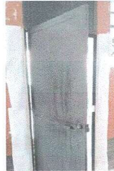
Foto 8: Mantenimiento de puertas en el segundo nivel
