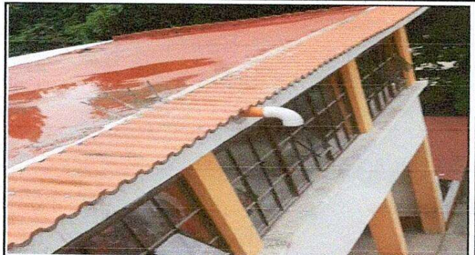
Foto 2: CANALES Y BAJADAS DE AGUA PLUVIAL (Reparación de bajadas pluviales existentes, se perforará losa del segundo nivel y paredes para colocar nuevas).
