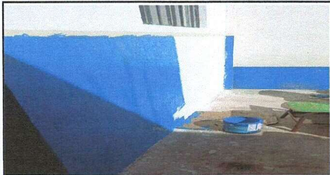
Foto: Proceso de pintura de ampliación de cocina.
