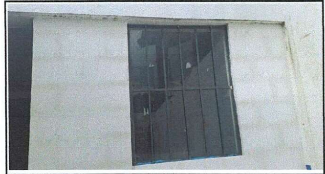
Foto 33: Ampliación de cocina realizada.
