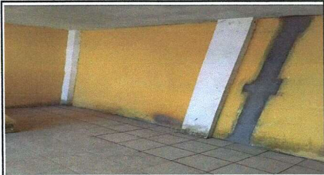
Foto 30: Bajadas de agua reparadas. Caja interior cegada.
