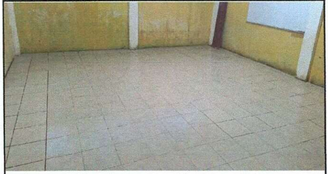
Foto 31: Piso de salón reparado.
