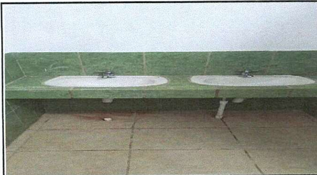
Foto 20: Lavamanos reparados y funcionando.
