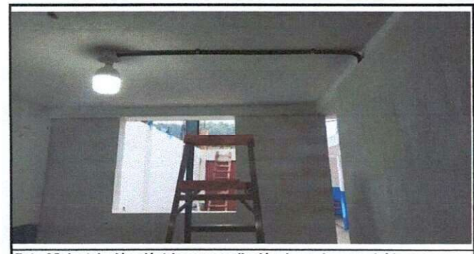
Foto 35: Instalación eléctrica en ampliación de cocina concluida.
