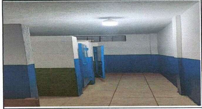
Foto 21: Módulo de baños restaurado.
