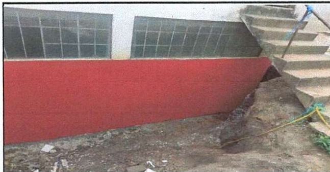
Foto 28: Muro exterior de salones, reparado.
