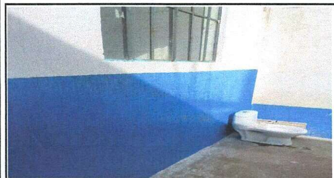
Foto: Muro exterior de cocina finalizado.
