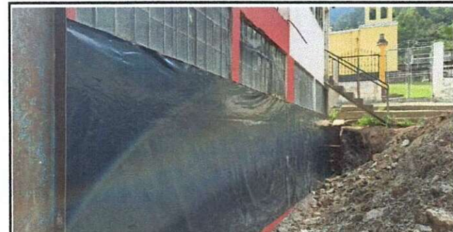
Foto 29: Muro exterior de salones, reparado.
