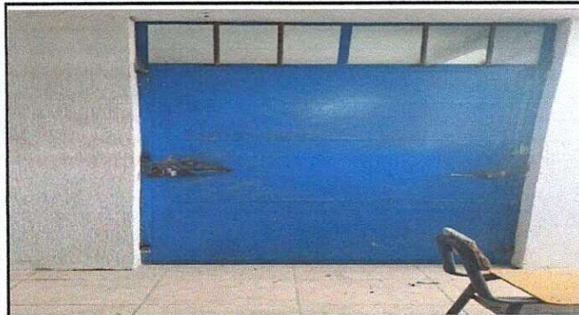
Foto 32: Ampliación de cocina realizada.
