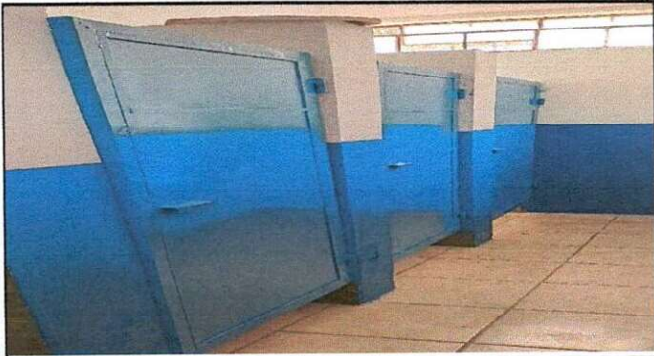
Foto 18: Sanitarios remodelados, puertas restauradas.
