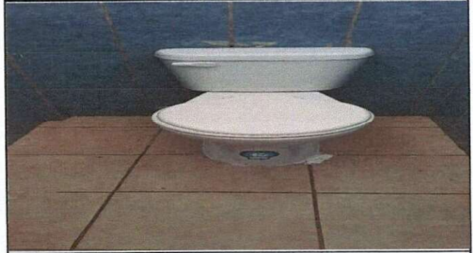
Foto 19: Sanitarios nuevos instalados.
