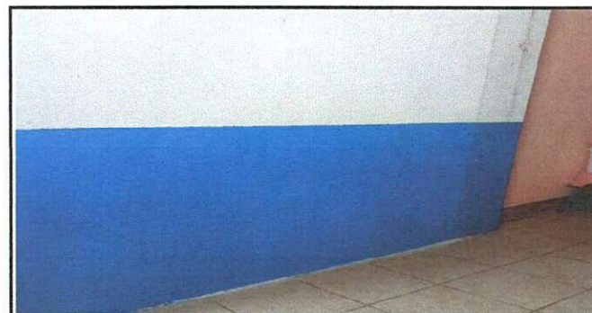
Foto: Muro exterior de cocina finalizado
