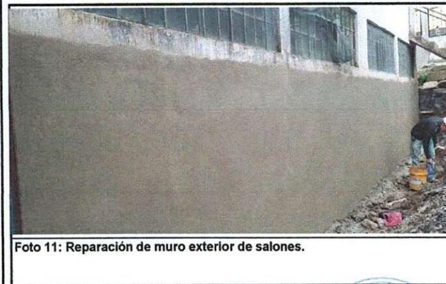
Foto 11: Reparación de muro exterior de salones.
