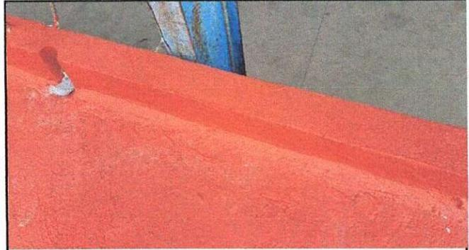
FOTO 8 Fundición de remates de terraza
