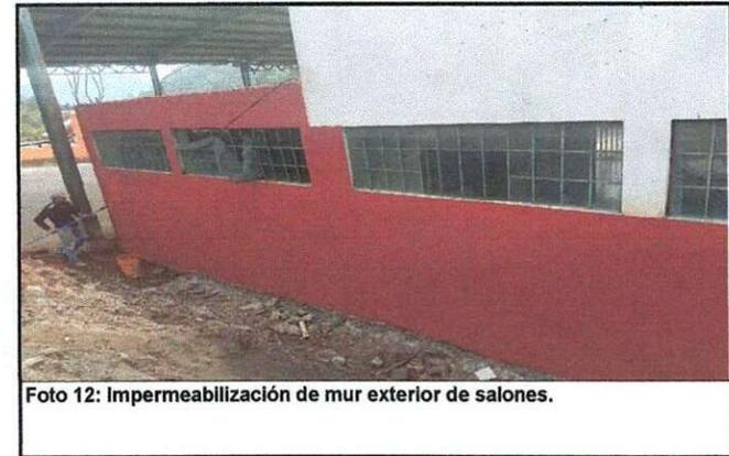
Foto 12: Impermeabilización de mur exterior de salones.
