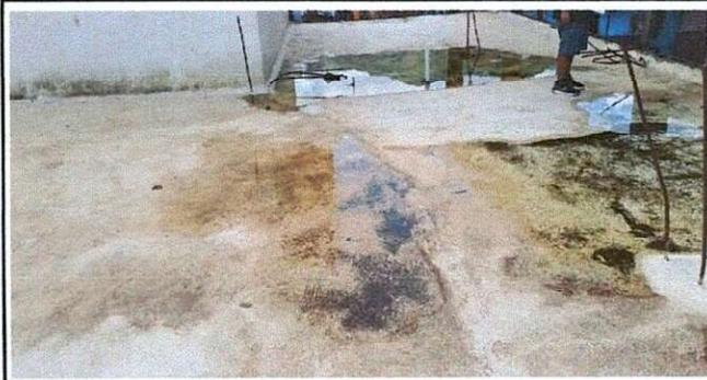
Foto 1: Estado actual de terraza, no tiene el desnivel necesario para evacuar el agua
