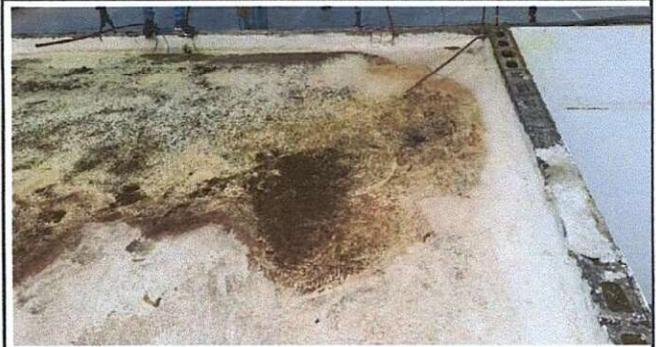
Foto 2: Estado actual de terraza, filtraciones de agua a través de los remates.
