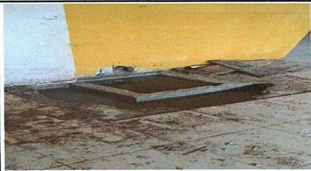
Foto 1: Drenaje pluvial en el interior de salón 1, colapsado, provocando inundación dentro del salón.
