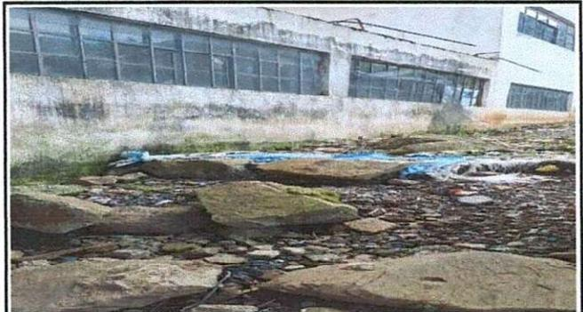
Foto 4: Muro exterior de salón 1 y 2, se necesita cavar zanja para trabajar la pared exterior.
