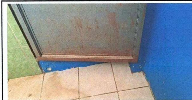
Foto 5: Puertas de sanitarios corroidas por el óxido.
