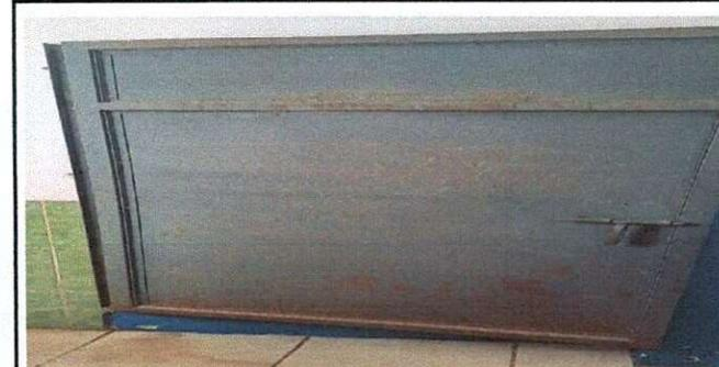
Foto 6: Puertas de sanitarios, corroidas por el óxido y destrabadas del marco.
