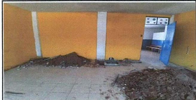
Foto 6: Estado actual de salón 1, caja colapsada, piso levantado, agujero en el piso y tierra acumulada.
