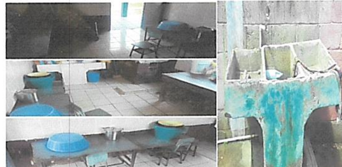
Foto 2: REPARACION O SUSTITUCION DE AREA DE COCINA (SUMINISTRO DE 3 MESAS DE CONCRETO DE(0.70X2.00X.80)(0.70X2.90X.60,INCLUYE 4 PUERTAS DE METAL DE0.50X0.70 CADA UNA)(0.70X1.20X0.80) FORRADO CON AZULEJO.
