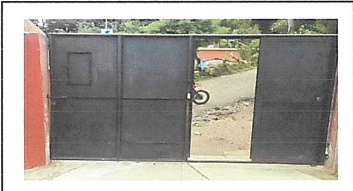
Foto 6: MANTENIMIENTO A PORTONES (MANTENIMIENTO DE PORTON PRINCIPAL DE 6 M2 CON REPARACION DE LIENZO DE LIENZO DE 0.30 METROS, LIMPIEZA, LIJADO Y PINTURA)
