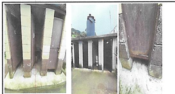
Foto 3-1,3-2,3-3: INSTALACION DE SANITARIOS BLANCOS,INSTALACION DE AGUA Y DRENAJES,REPARACION DE TECHO DE LAMINA DE SANITARIO,INCLUYECAMBIO DE LAMINATROQUELADACALIBRE 26.REFORZAMIENTO DE BASE METALCALIADO Y PINTURA, MANTENIMIENTO DE PUERTAS CAMBIO DE LIENZO A 3 DE LAS 7 PUERTAS.
