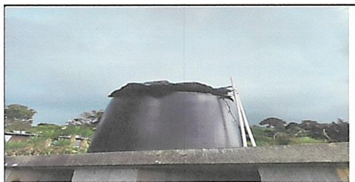
Foto 4: INSTALACION Y MANTENIMIENTO DE DEPOSITOS DE AGUA: SUMINISTRO EINSTALACION DE 2 TINACOS PARA AGUA CON SU RESPECTIVATUBERIA PVC Y REPARACION Y MANTENIMIENTO DE 1 TINACO YA EXISTENTE EN LOS TRES DEPOSITOS INCLUYE ACCESORIOS
