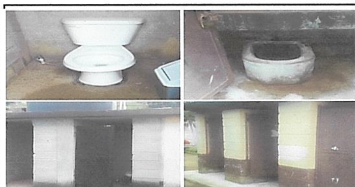
Foto 3: SERVICIOSANITARIO Y SUS ACCESORIOS (CAMBIO DE ACCESORIOS DE SANITARIOS)
