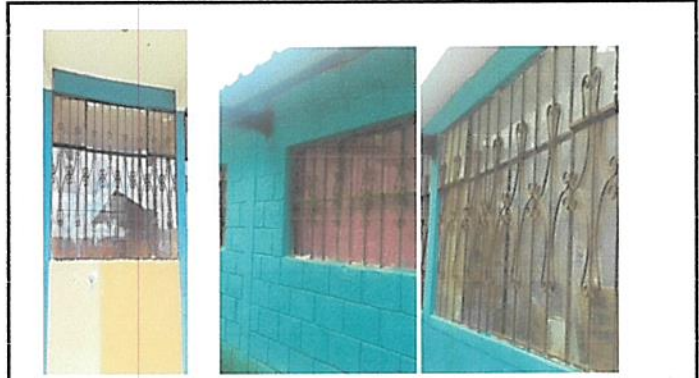
Foto 7: VENTANAS: MANTENIMIENTO A 52 A 52 MT2 DE BALCONES (Limpieza, lijado y pintura)
