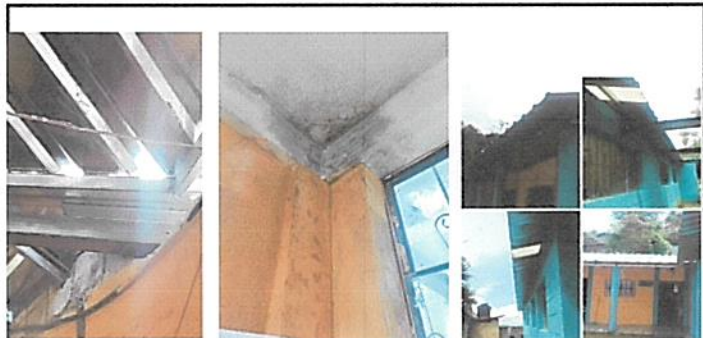
Foto1: CANALES Y BAJADAS DE AGUA PLUVIAL (SUSTITUCION DE CANAL METALICO DE 44.00 MTS. CON 2SUJETADORES METALICOS EN AREA DE BODEGA DE ALIMENTOS. SUMINISTRO E INSTALACION DE BAJADAS PLUVIALES 12.00 UNIDADES, Y REPARACIÓN DE BAJADA PLUVIAL DE PARED.
