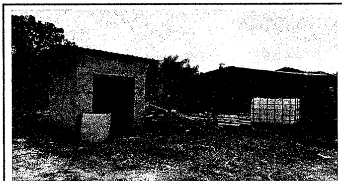
Foto 3: Instalacion de cisterna Rotoplast, red de agua potable.
