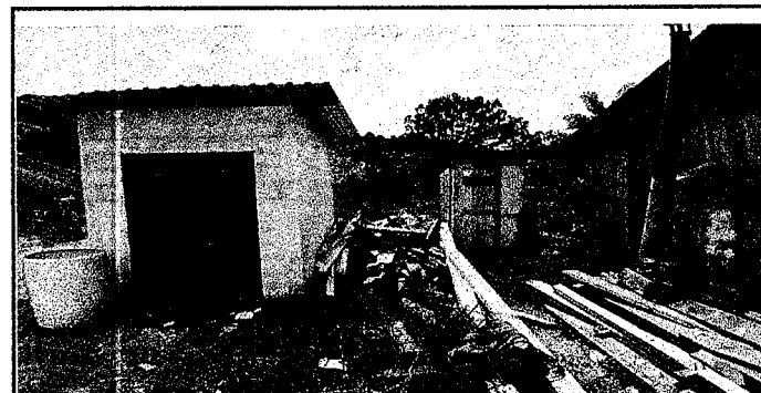
Foto 6: Reparacion de red de drenaje y red de agua potable
