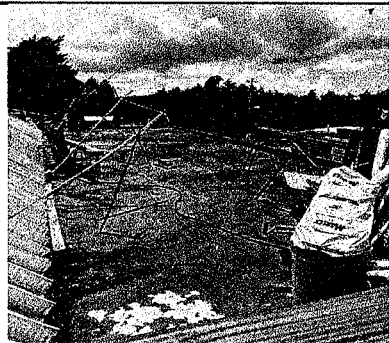
Foto 5: Impermeabilización de losa, se necesita terminar de impermeabilizar la losa y de esta forma evitar filtraciones de agua.
