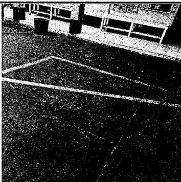
Foto 1: Hundimiento por deterioro de losa, se puede notar un notable hundimiento y al momento de pisar esa area se puede sentir un pequeño movimiento.
