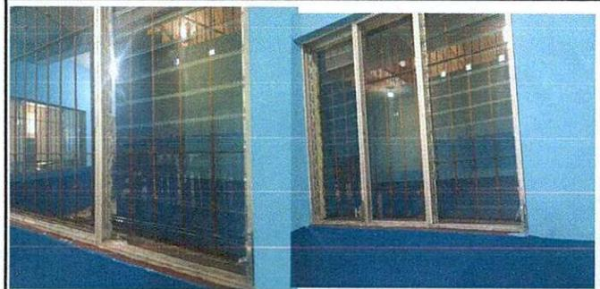
**Foto 2: ÁREA DE MODULO DE VENTANAS:** Sustitución de paletas de vidrios en salones de clases, 30 ventanas en total, se sustituirán accionamiento y empaques.
