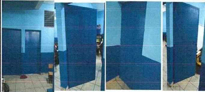
**Foto1: ÁREA DE MODULO DE PUERTAS:** Mantenimiento de 10 puertas, lijado y pintado a dos manos en ambas caras, puertas de 0.90 x 2.10.
