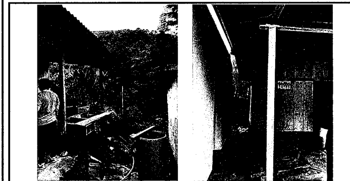
FOTO 09 Y 10: AREA DE COCINA, PAREDES DE MADERA EN MAL ESTADO Y TECHO, SE SUSTITUIRAN POR PAREDES DE BLOCK Y CUBIERTA DE LAMINA Y ESTRUCTURA DE METAL.
