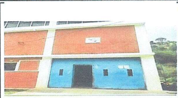
Foto 1: Área: Portón principal, limpieza, lijado y pintura
