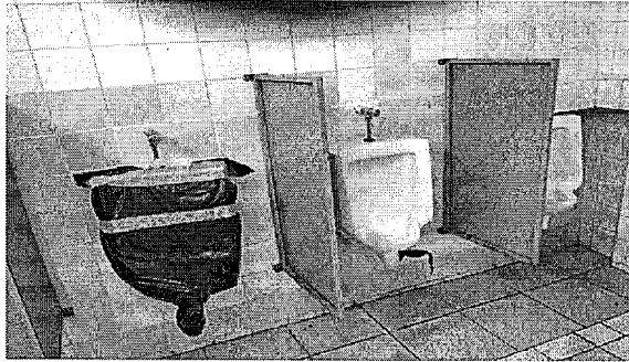
Foto 1: Mantenimiento y sustitucion de accesorios de urinales y artefactos sanitarios de los modulos de sanitarios.
