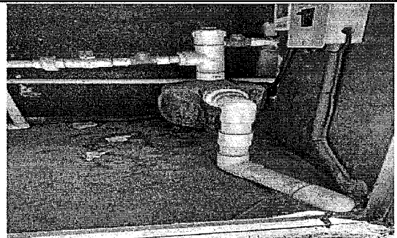
Foto 6: Mantenimiento de bomba y readecacion de sistema electrico de bomba.
