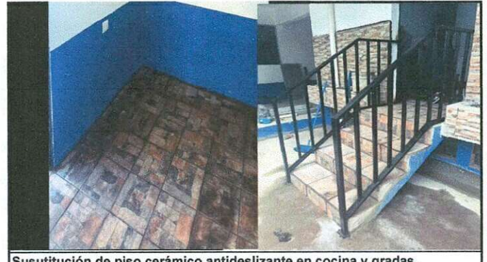
Susutitución de piso cerámico antideslizante en cocina y gradas.
