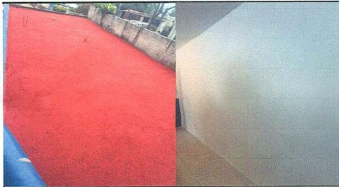
Impermeabilización de loza.
