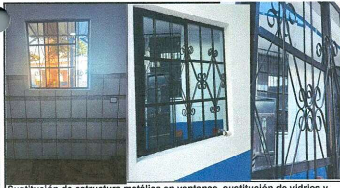
Sustitución de estructura metálica en ventanas, sustitución de vidrios y balcones de metal en 3 ventanas.
