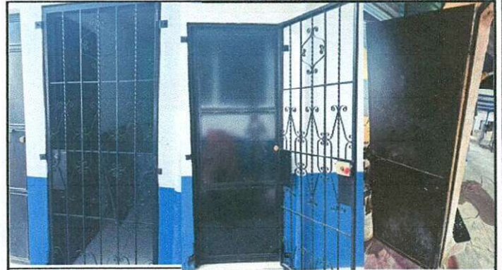
Mantenimiento de estructura, lijado y aplicación de pintura a puerta y reja, sustición de puerta metálica.
