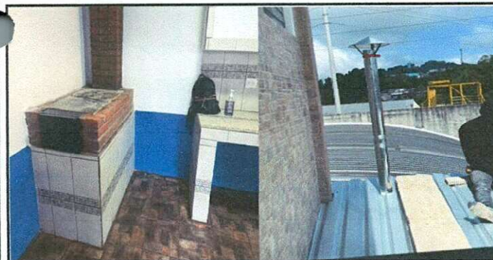
Elaboración de una cocina de leña con plancha, incluida la chimenea.
