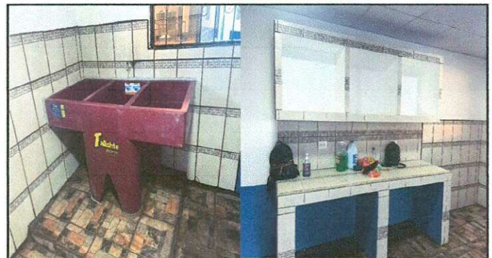
Reparación o sustitución de área de cocina, sustitución de pila de dos lavaderos, instalación de planchas de concreto (mesón).
