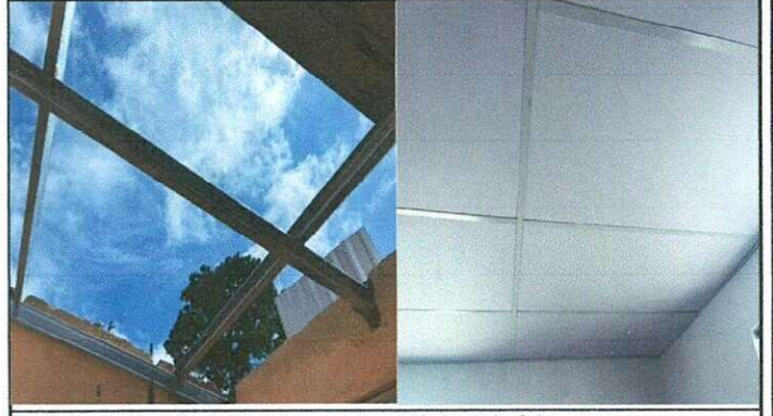
Sustitución metálica de techo y colocació de cielo falso.
