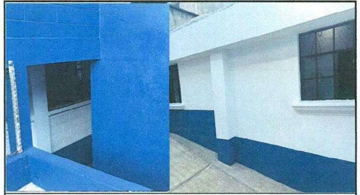
Pintura de exteriores área de cocina básicos, primaria y salon de computación.
