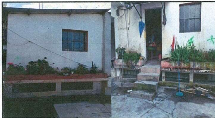
Susustitución de azulejo azulejo y fachaleta en área de cocina.
