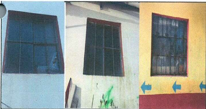
Sustitución de estructura metálica en ventanas, sustitución de vidrios y balcones de metal en 3 ventanas.
