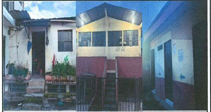
Pintura de exteriores área de cocina básicos, primaria y salon de computación.
