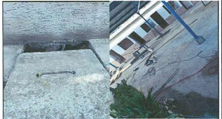
Reparación de red de agua potable, sustitución de tubería PVC, sustitución de tubería PVC de aguas pluviales, sustitución de llave de chorro.
