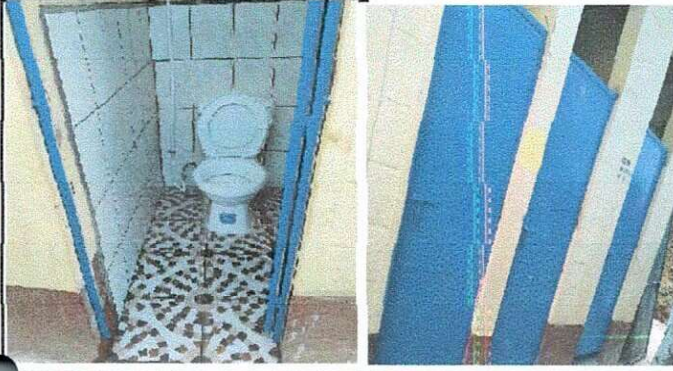
Foto 1: Mantenimiento de puertas y sustitucion de inodoros de cemento, por inodoros de los.
