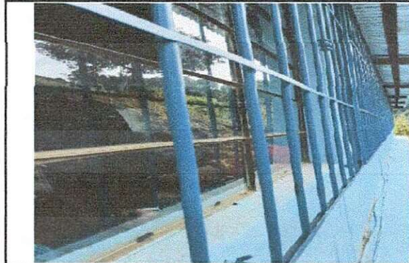
Foto 2: Instalacion de Balcones metalicos en ventanas de segundo nivel.
