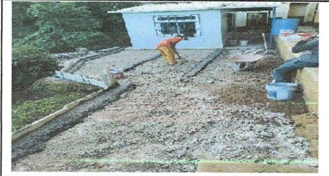
Foto 6: Fundición de concreto en patio
