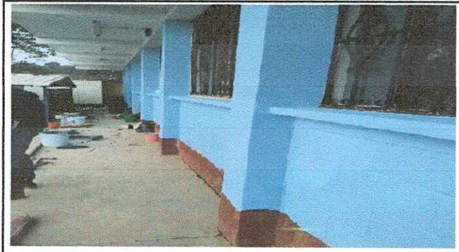
Foto 4: Pintura en muros interiores y exteriores, en diferentes areas.
