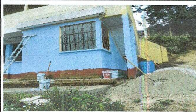
Foto 3: Mantenimiento de estructura de ventanas existentes.
