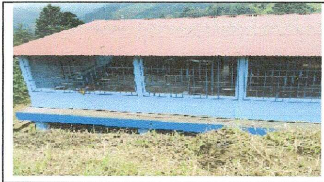
Foto 2: Instalacion de Balcones metalicos en ventanas de segundo nivel.
