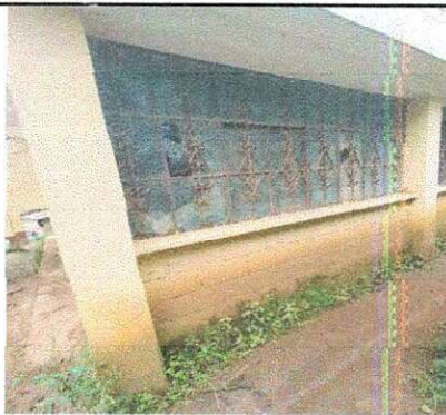
Foto 3: Mantenimiento de estructura de ventanas existentes.
