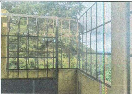
Foto 5: Mantenimiento de barandal existente.
