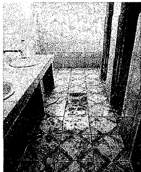
Foto 1 y 2 cambio de piso ceramico por piso ceramico antideslizante en sanitario para hombres
