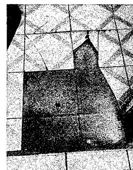
Foto 5 y 6 cambio de piso ceramico por piso ceramico antideslizante en sanitarios para mujeres
